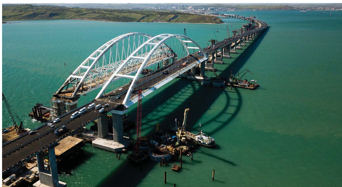
Артерия жизни – строительство Крымского моста с привлечением спецтехники XCMG
